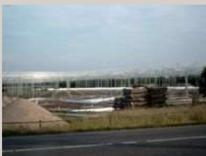
21 juni: Grote nieuwbouw kassen bij Komkommerbedrijf Jan Beijnsberger
