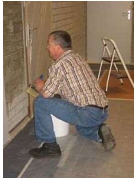
zelfwerkzaamheden in 't Erf
