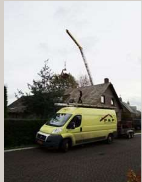
Dakwerkzaamheden aan de Gielenhofweg
