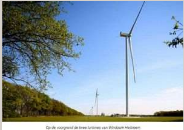
Op de voorgrond de twee turbines van Windpark Heibloem.
